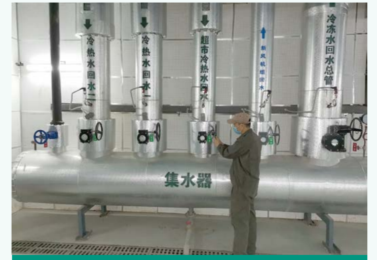
暖通师傅对供水阀门进行流量调节
