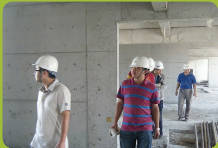
在建项目第三方季度巡检
